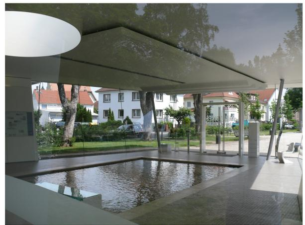
Ein Glaspavillon der ein altes Römer-Mosaik in Szene setzt, welches im Jahr 1848 beim Bahnbau in Bad Vilbel entdeckt wurde. Hier wurde die Glasfassade als Ganzglasfassade konstruiert. Die Gläser werden zweiseitig gelagert. Ganzglasecken verleihen der Konstruktion ihre Leichtigkeit.
